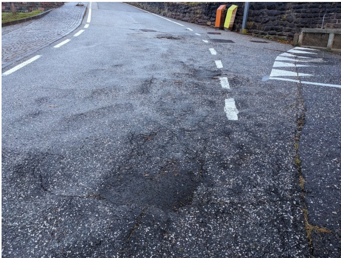
Pavimentazione a valle del pozzetto
