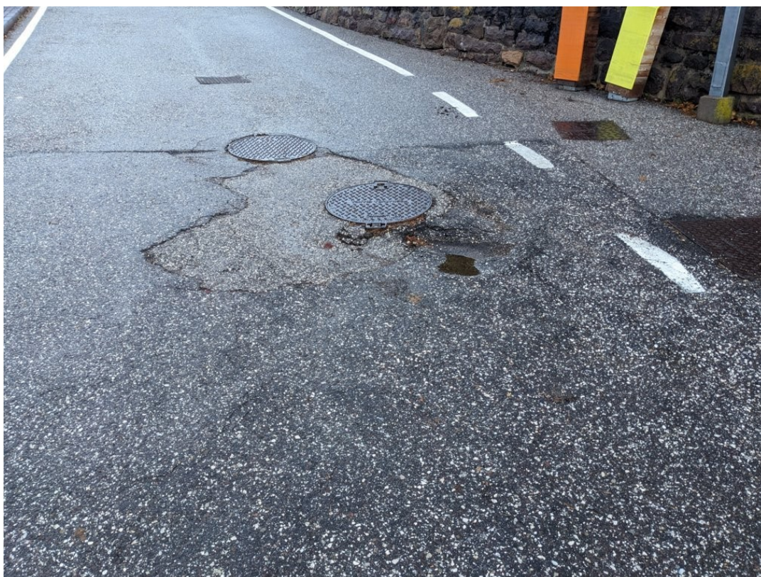
Pozzetto all'incrocio presso il cimitero
