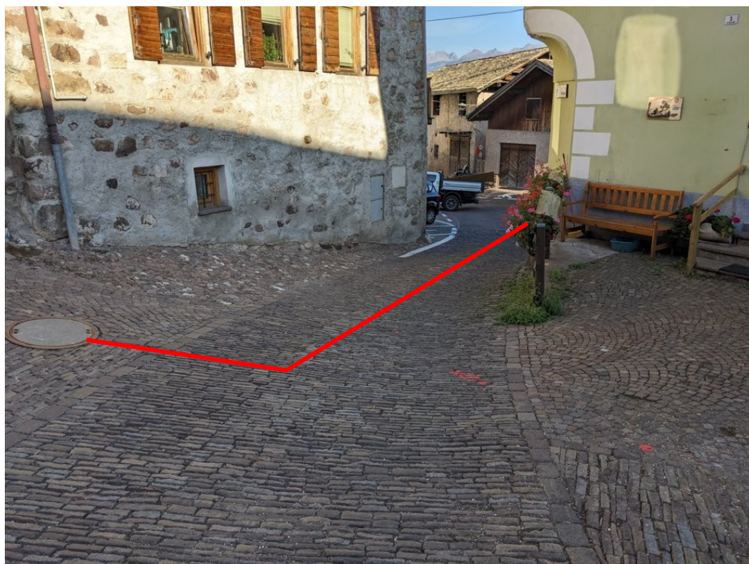
Tracciato tubazione acquedotto da sostituire (via Morandel)
